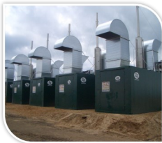
Landfill Gas CHP
