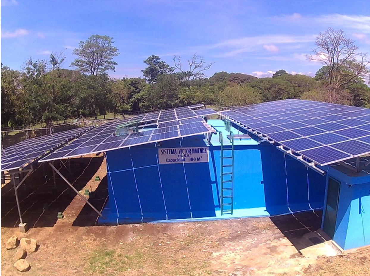
Solar Costa Rica recientemente instaló 160 paneles para proporcionar la energía que hace funcionar el primer pozo de agua municipal en América Central y que funciona con energía solar fotovoltaica. La instalación junto con el control automático motores ha reducido los costos de facturación eléctrica aproximadamente en ₡1 000 000 por mes. Los ahorros previstos en el sistema durante 25 años (periodo de garantía de los paneles) es de más de trescientos millones de colones.
